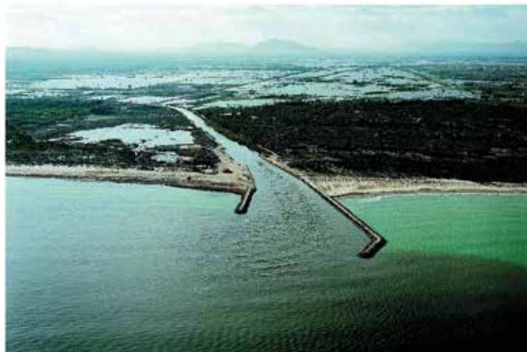
Figura 2. La Vega Baja y desembocadura del río Segura, tras la inundación del año 1988.
