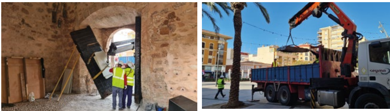
F.3. Proceso de desmontaje de las puertas
