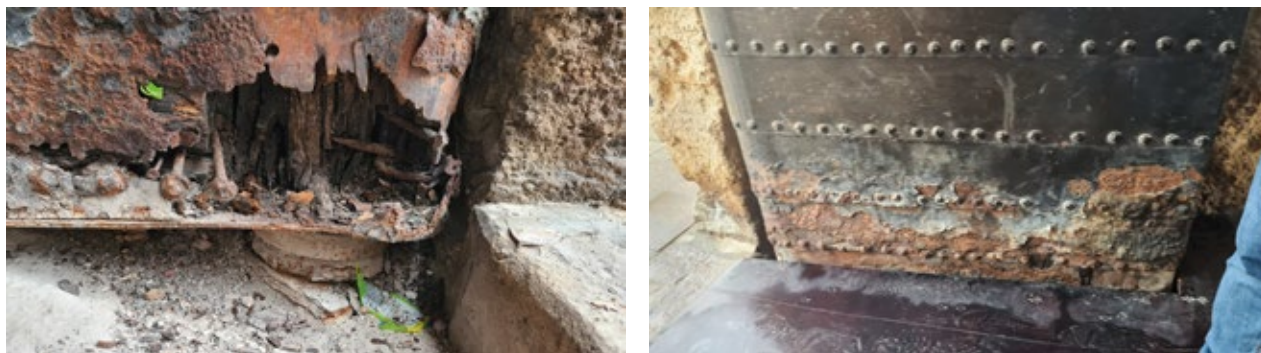
F.2. Detalle de los daños sobre el metal y la madera de las zonas inferiores de ambas puertas. Autor: Eva Mendiola.
