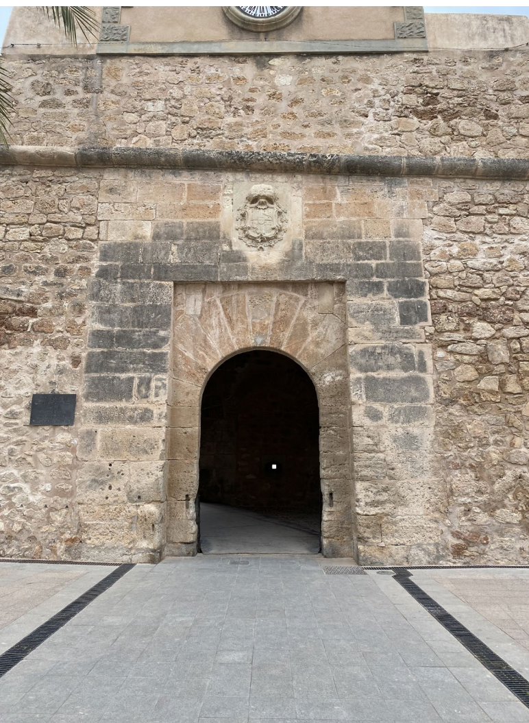
Foto 3.1.6.1. - Acceso de poniente
