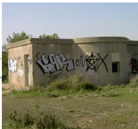
Foto 3.5.21. - Caseta de oficiales
