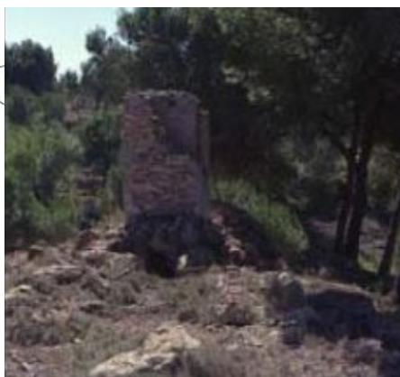
Foto 3.5.33. - Aljibe de Calín
