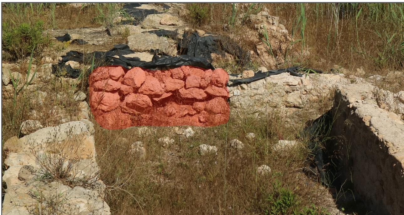
Figura 8.14. Vista en detalle de uno de los muros de la zona de la cetaria donde marcamos (en rojo) la pérdida de piezas por la desintegración de su trabazón.
