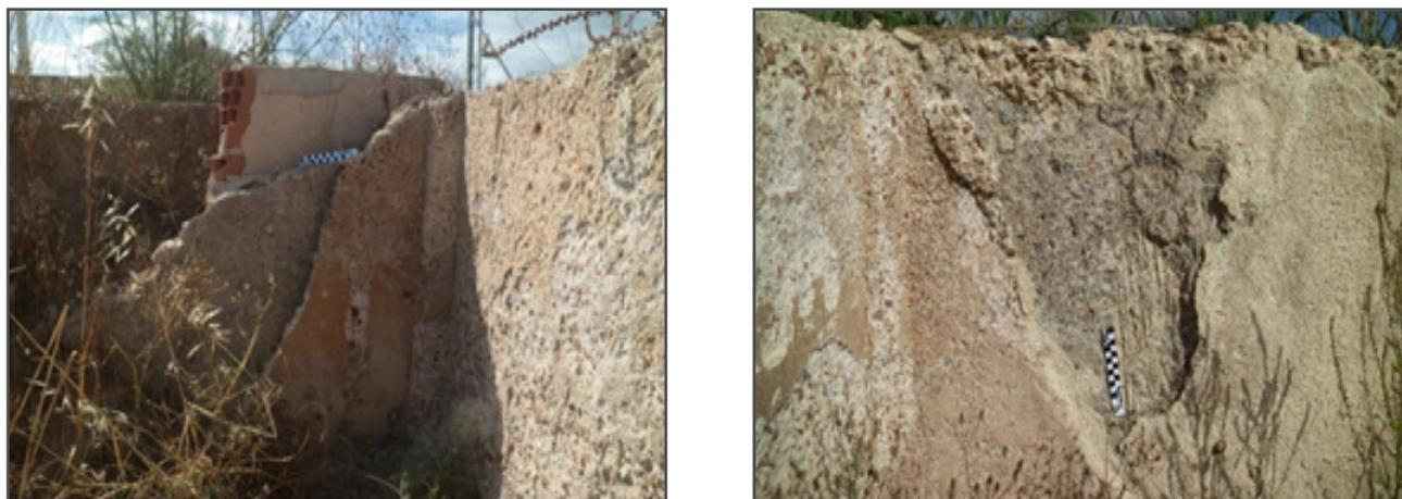
Figura 8.18. Vistas en detalle del estado actual de los revestimientos hidráulicos de la cisterna, en la que se aprecian zonas marcadas por desprendimientos parciales.
