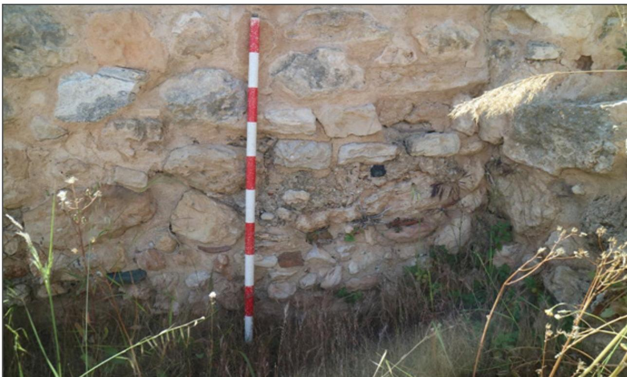
*Figura 8.17. Vista en detalle de un lienzo murario de la zona de la cetaria en la que se aprecian el estado de conservación del mortero de restauración de 2003-2004, con grietas y desprendimiento parcial del mismo.*
