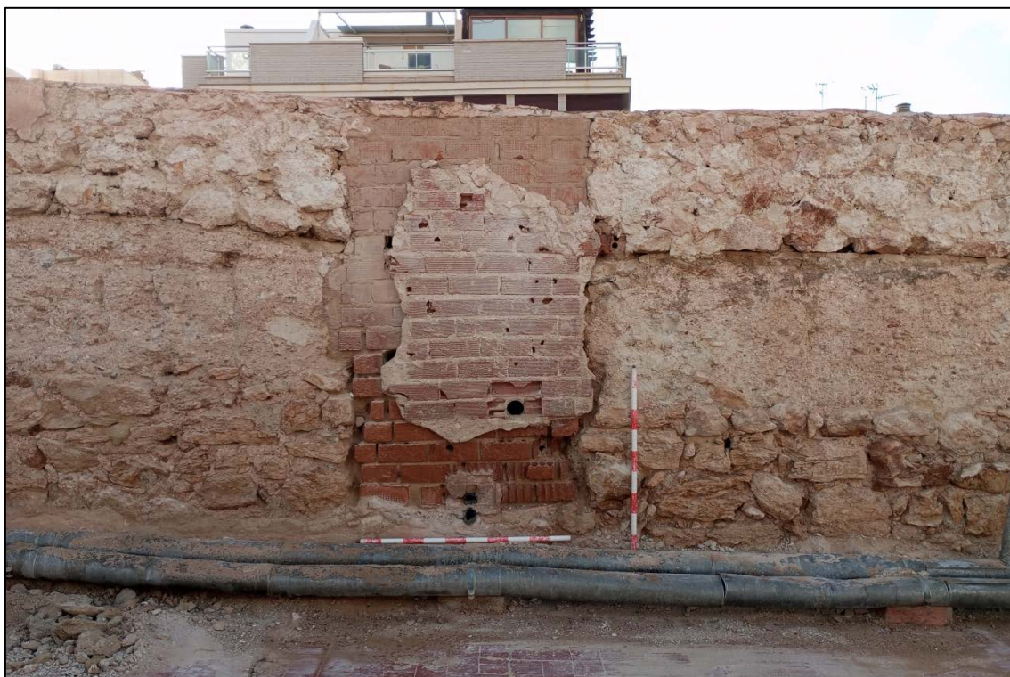
Vista en detalle de parte del paramento del frente este tras la retirada de los enlucidos
