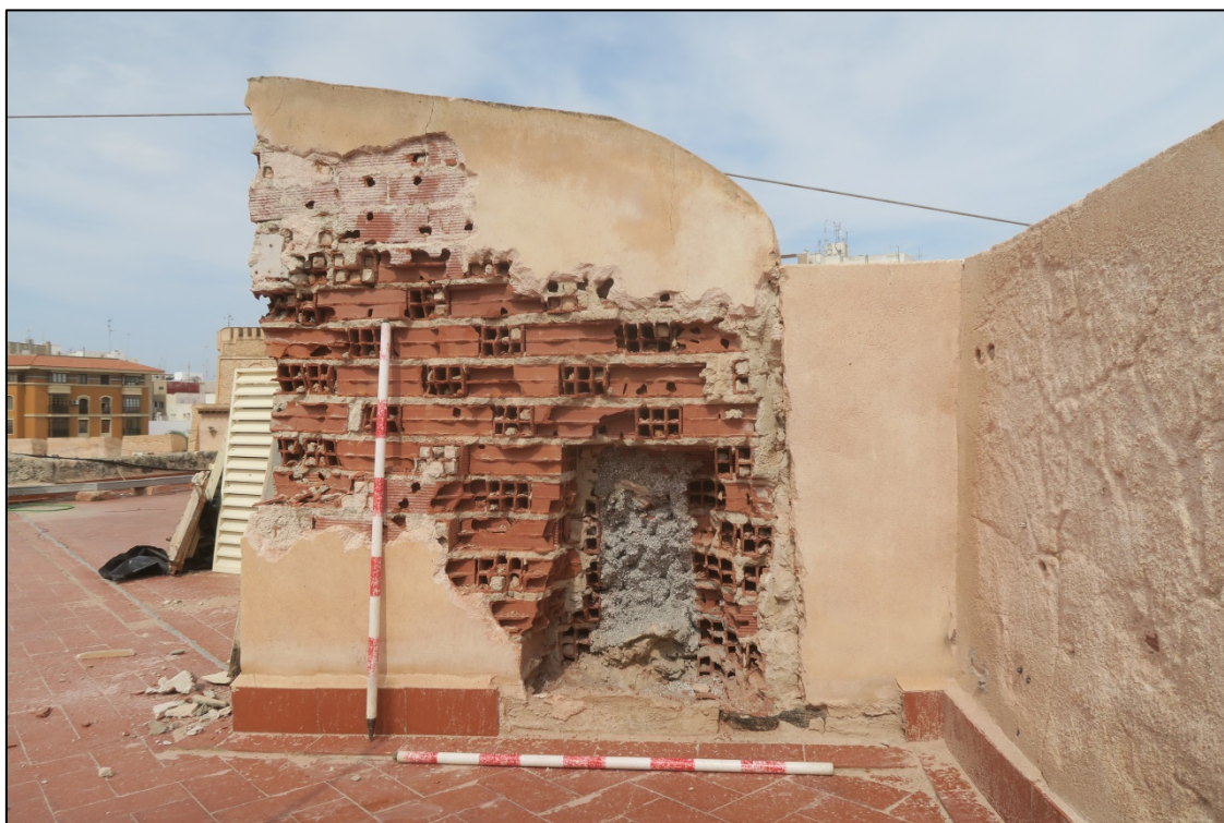
Alzado del frente norte realizado con ladrillo hueco
