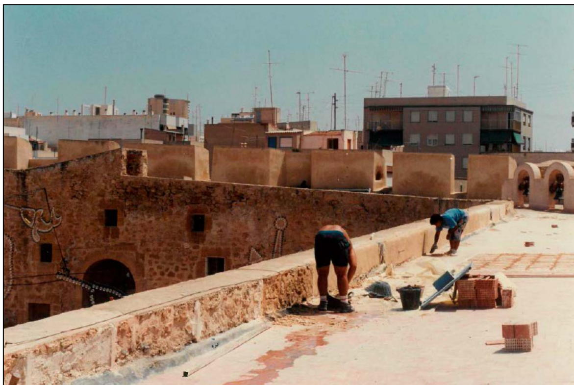
Fotografía de 1974 donde se observar el frente este sin el tapiado del almenado
