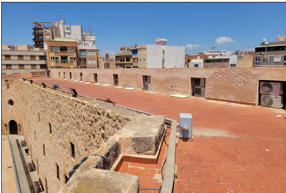
Estado del frente norte antes del inicio de la intervención
