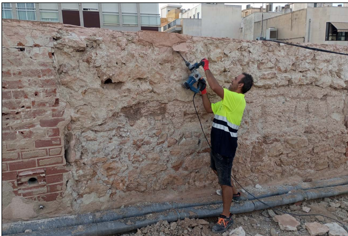
Desarrollo de los trabajos de repicado de los enlucidos
