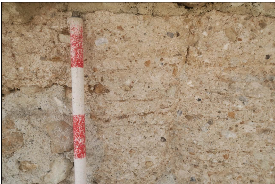
Vista en detalle de la fábrica de tapia original
