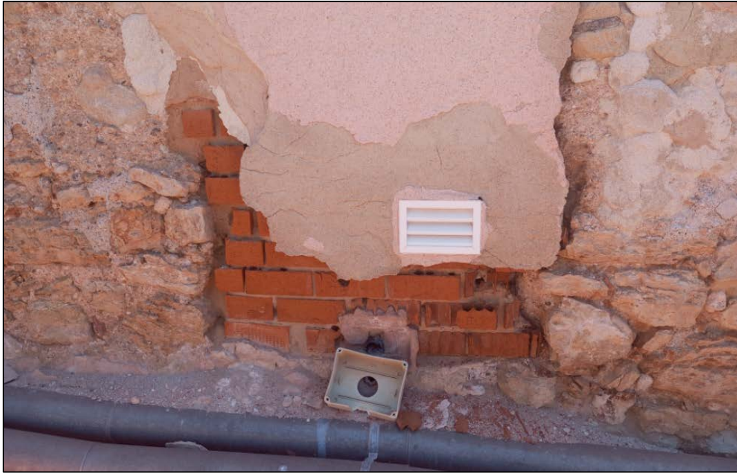
Vista del tapiado de una de las troneras del frente este
