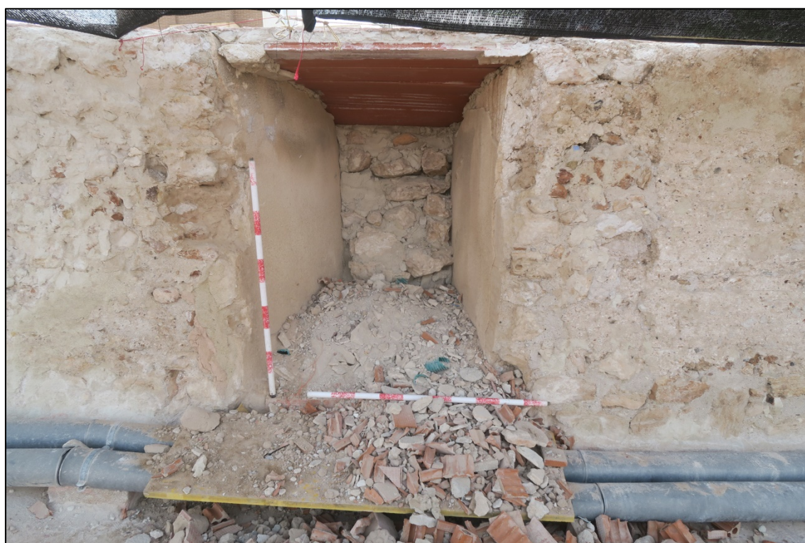
Vista del interior de una de las almenas tras la retirada de la tapia interior
