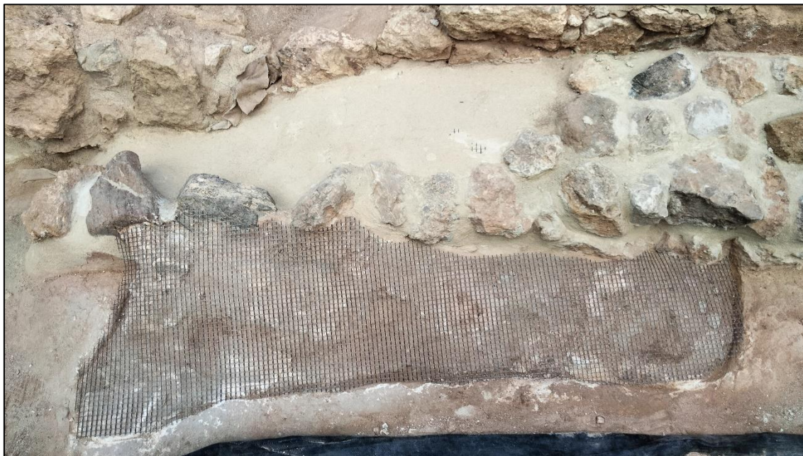
Vista del proceso de encapsulamiento de parte de uno de los bancos corridos del edificio romano
