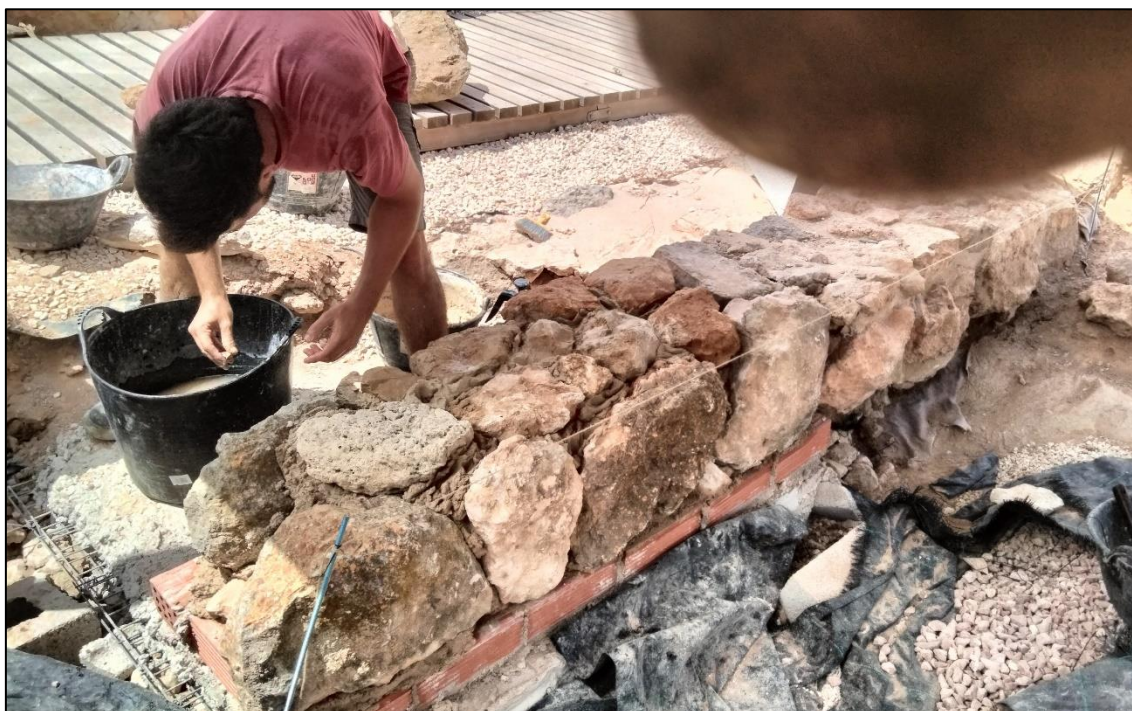
Vista del proceso de reconstrucción de uno de los muros perimetrales del edificio romano
