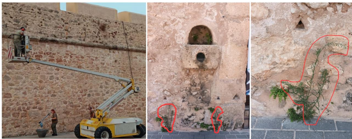
Figura 3: Tareas de identificación y mantenimiento para el saneamiento y eliminación de plantas invasoras en el Castillo-Fortaleza.
