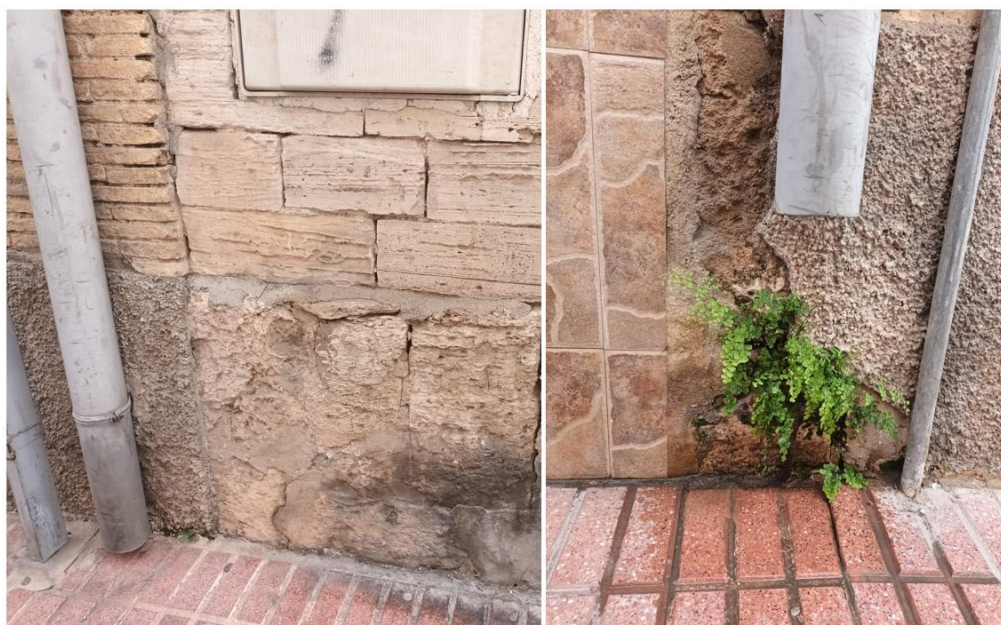
Vista general y detalle de la distribución de Culantrillo de Pozo sobre la facha exterior del edificio de atarazanas en la Calle Espoz y Mina 23-25
